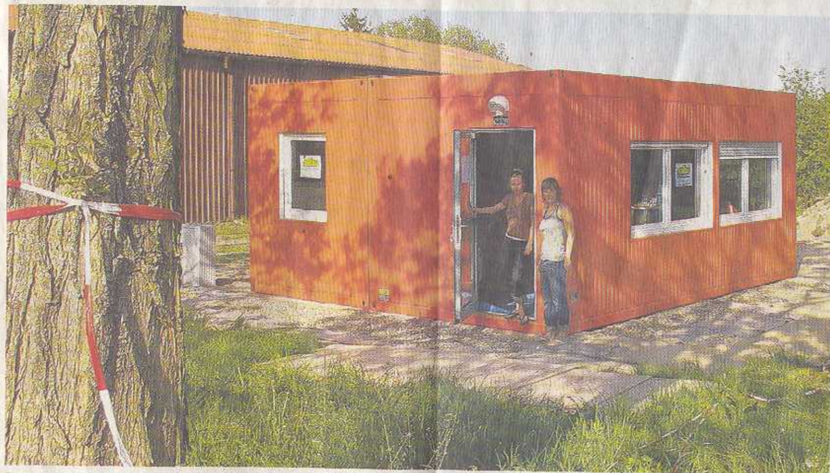
Baustellenfoto vom 13. Mai am Tag der Containermontage. Inzwischen ist die Berlin-Usedom-Box und das Umfeld hergerichtet für den Start am 24. Mai. Zum 300 Meter entfernten Strand des Unteruckersees gibt es einen direkten Zugang für die Gäste.
